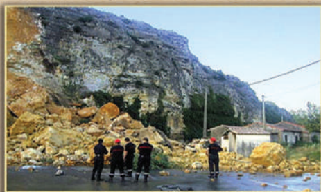
Éboulis obstruant la chaussée de la RD 26, le 17 juin 2003.
