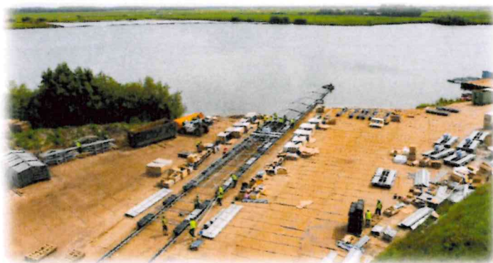
Exemple de zone chantier (période d'assemblage et de mise à l'eau des flotteurs et panneaux)
